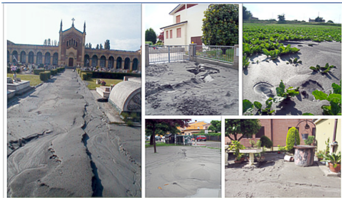
Fig. 22. Liquefaction phenomena at S. Carlo (from Vannucchi et al., 2012). Manifestazioni di liquefazione a S. Carlo (da Vannucchi et al., 2012).
