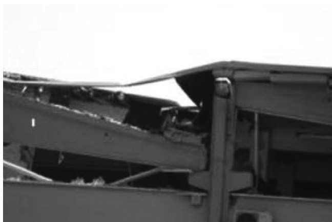
Fig. 16. Deficiency due to inadequate connections among structural elements (DPC, 2012). Problemi conseguenti connessioni tra elementi strutturali non adeguate (DPC, 2012).
