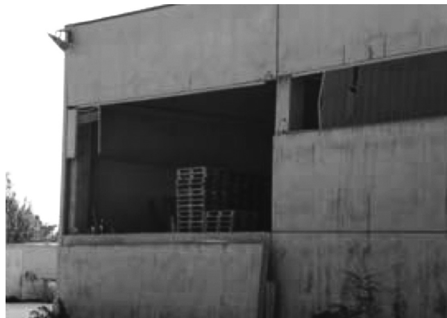
Fig. 17. Deficiency due to inadequate connections between cladding panels and structural elements (DPC, 2012). Problemi legati a connessioni tra elementi strutturali e pannelli di facciata non adeguate (DPC, 2012).
