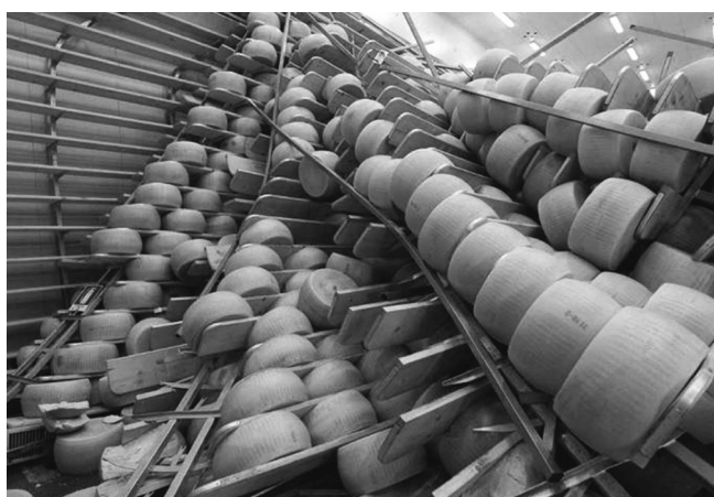
Fig. 18. Deficiency due to shelf units without bracing. Crollo di scaffalature non controventate.
