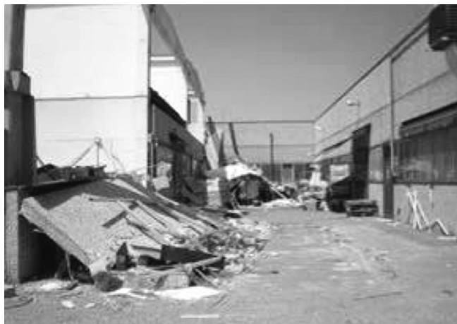
Fig. 17. Deficiency due to inadequate connections between cladding panels and structural elements (DPC, 2012). Problemi legati a connessioni tra elementi strutturali e pannelli di facciata non adeguate (DPC, 2012).
