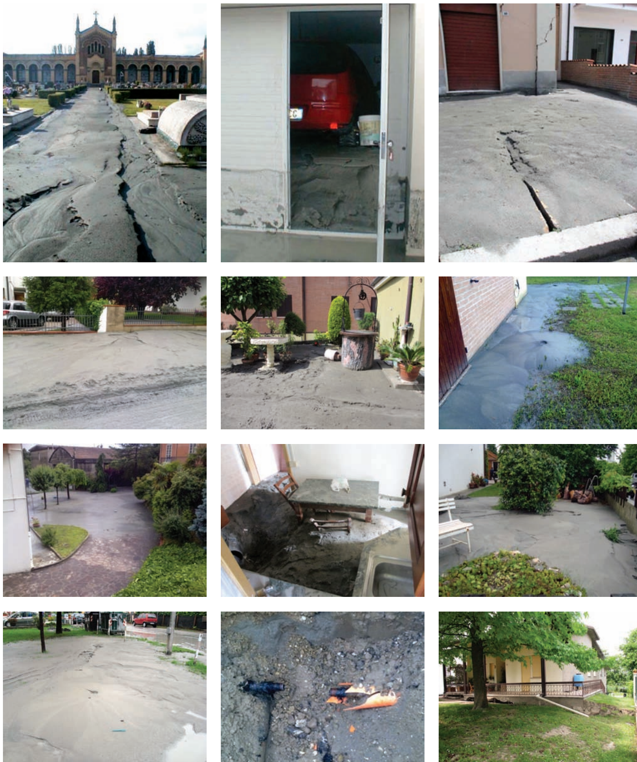
Fig. 3. Liquefaction evidences and damages at San Carlo (photos by DICeA Geotechnical team). Evidenze di liquefazione e danni a San Carlo (foto DICeA gruppo Geotecnico).
