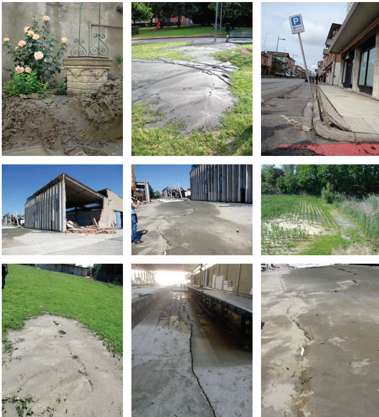
Fig. 4. Liquefaction evidences and damages at Mirabello (photos by DICeA Geotechnical team). Evidenze di liquefazione e danni a Mirabello (foto DICeA gruppo Geotecnico).
